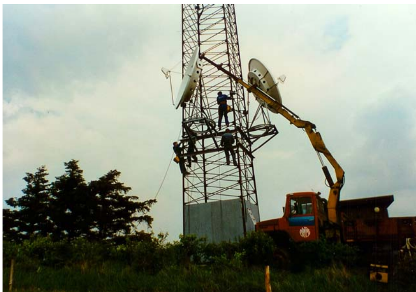
Arbejdet i gang med rejsning af masten i Hejnsvig i1981
