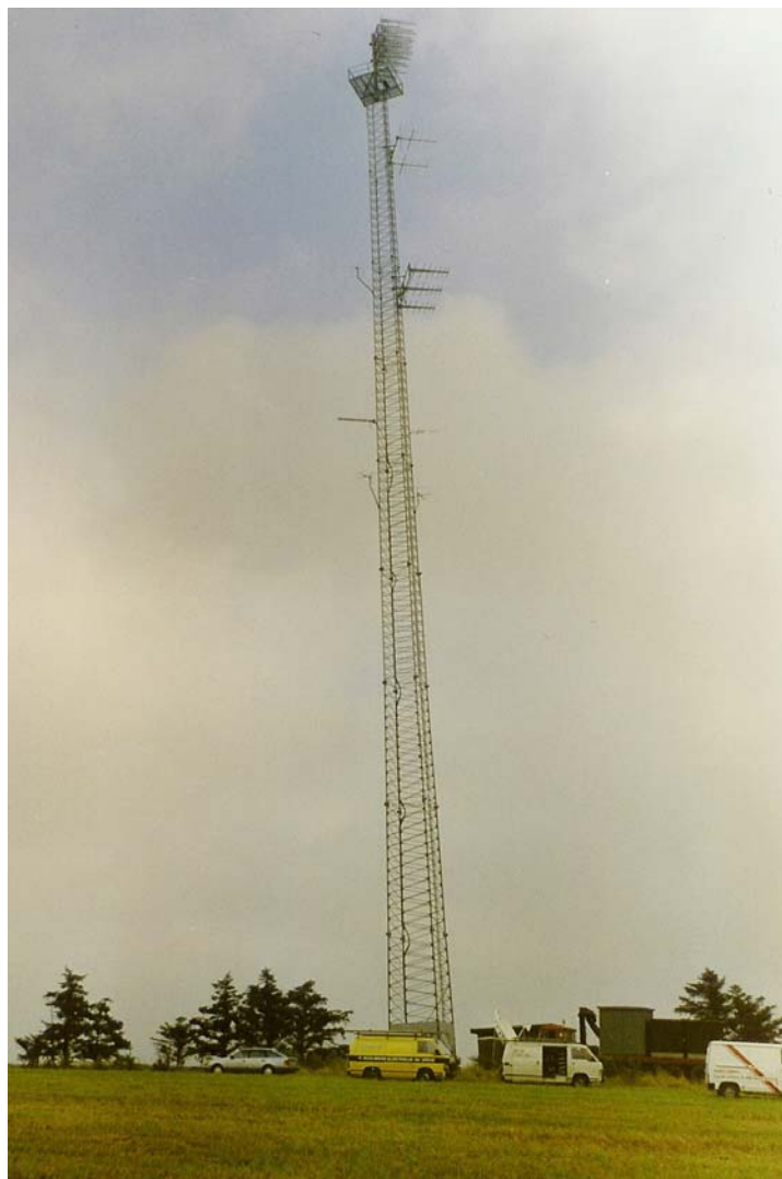
67,5 meter Mast i Hejnsvig 1981
